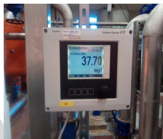
Slika 9: Prikaz meritve koncentracije nitratov na iztoku iz vodarne Medlog
