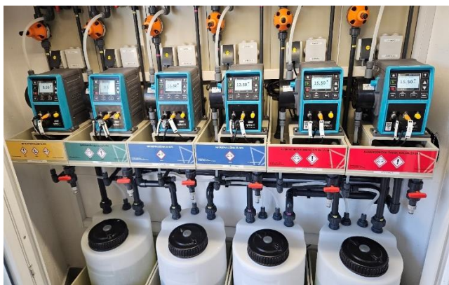
Slika 5: Sistem za doziranje kemikalij v Vodarni Gojka
